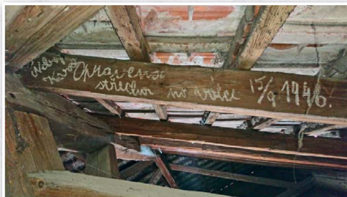
Důkaz o opravě střechy v roce 1946 – nalezeno při rekonstrukci v létě 2020
