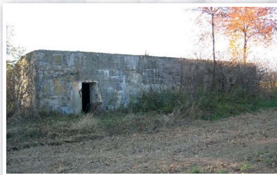
Dnešní stav jednoho z mnoha betonových bunkrů rozsetých po celém prostoru.
